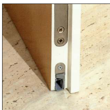
Détail d'une plinthe SK1
